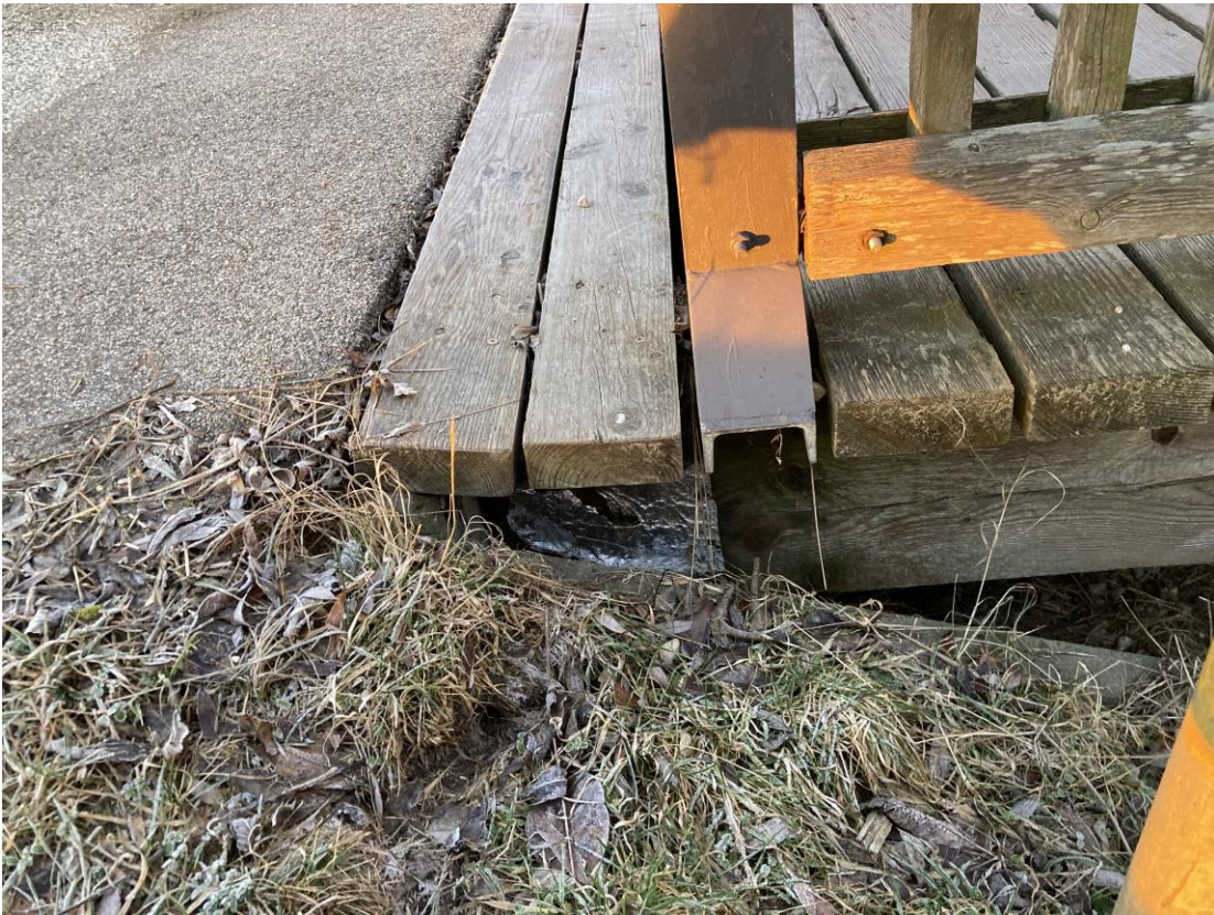
Bestandsauflager mit Abdichtung
