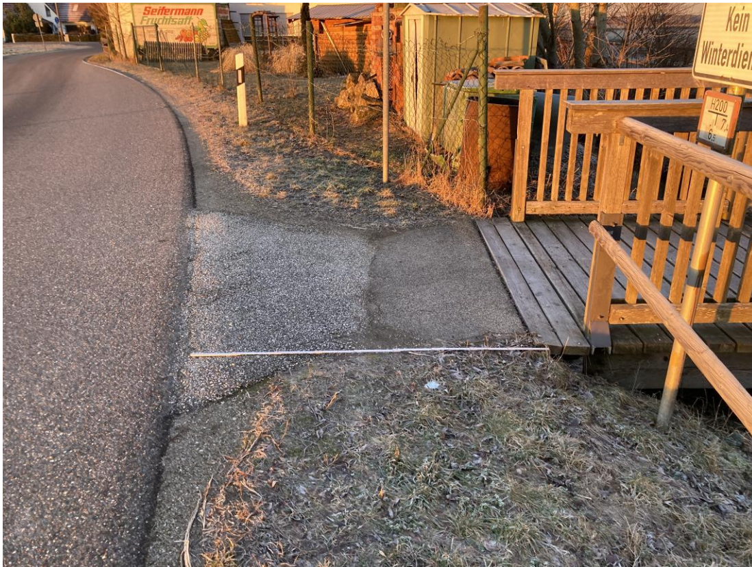
Zugang Riedelstr. zur Bestandsbrücke
