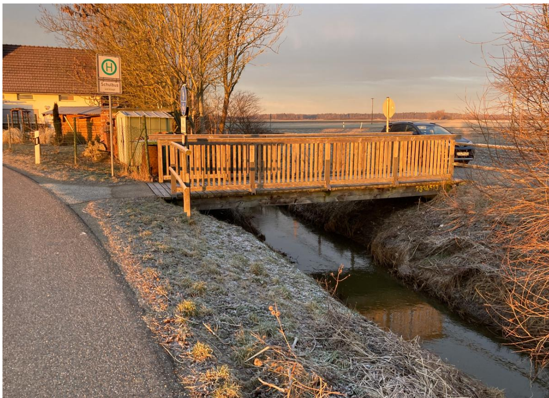
Bild: Zugang Riedelstraße
